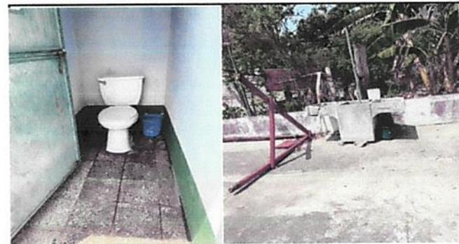
Foto 6: Mantenimiento a dos sanitarios con sus respectivos accesorios, y instalación de una pila de dos lavaderos.
