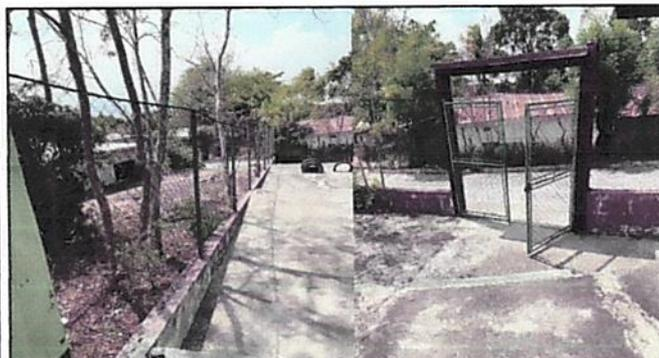
Foto 3: Construcción de muro perimetral, e instalación de porton con su respectiva chapa yale, así mismo el repello y cernido del interior y exterior de la pared de enfrente.
